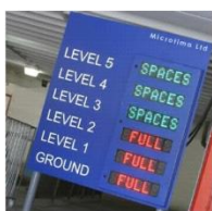
Afișaj al unui Sistem avansat de parcare
